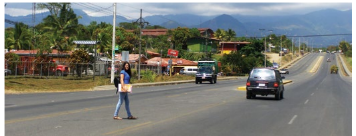
Puente peatonal. Ruta 2, Sector San Diego de Tres Ríos Fuente: Archivo LanammeUCR, 2009
