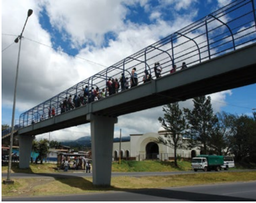
Cruce de peatones Ruta 2, Sector San Isidro-Río Convento Fuente: Archivos LanammeUCR, 2012.
