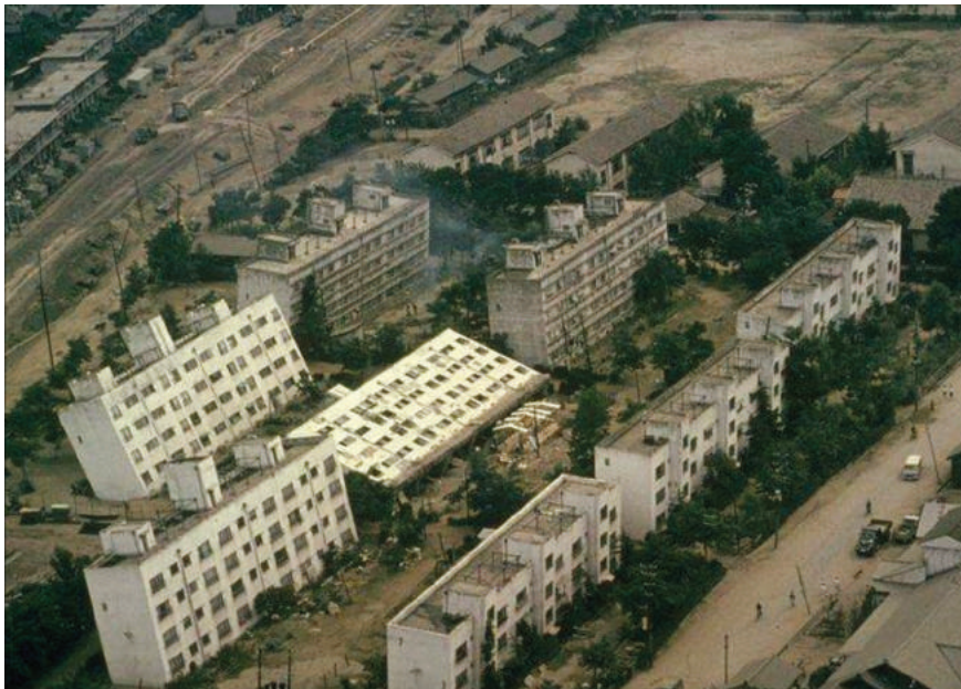
Fotografía 1. Volcamiento de complejo de apartamentos Kawagishi-cho por falta de capacidad de soporte a raíz del terremoto de Niigata, Japón (1964).
