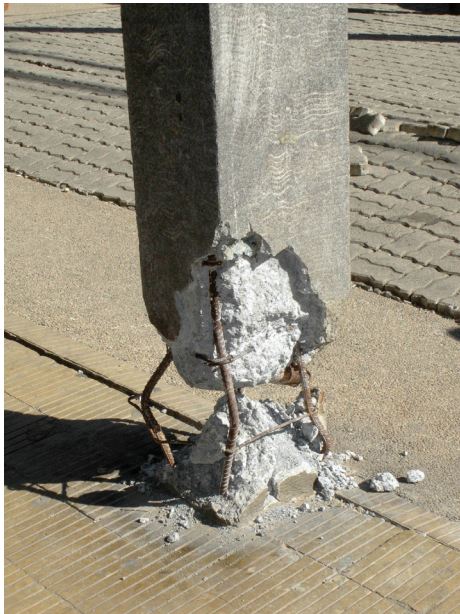
Detalle de columna de edificio
