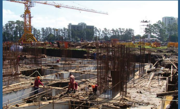
La cimentación consta de pilotes de concreto, sobre los cuales se colaron placas de fundación y vigas de amarre entre ellas.
