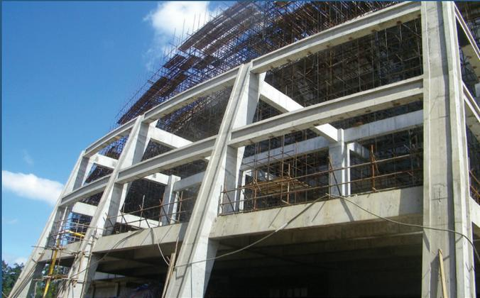
El Estadio funciona con un sistema a base de columnas, vigas y muros de corte, cumpliendo con los Códigos Sísmicos de Costa Rica y China. Para concluir la obra gris solo falta una losa de unión entre las graderías este y norte.
