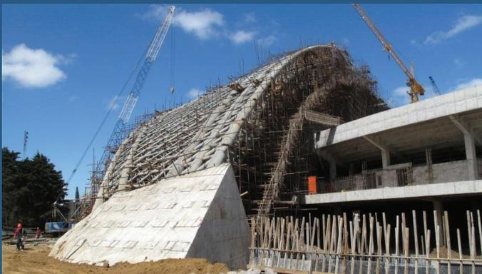
La estructura del techo está compuesta en las dos graderías este y oeste por seis arcos en su parte interna y tres arcos en la parte externa, unidos entre sí con estructuras espaciales a base de tubo de diferentes diámetros. Tiene dos apoyos en el piso y 22 apoyos móviles en la parte alta de la gradería, que transmiten carga vertical.
