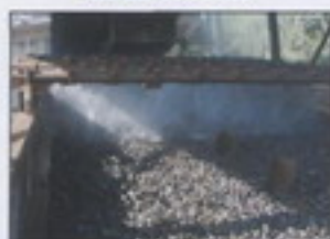
Figura # 2. PROCESO DE LAVADO DE AGREGADO GRUESO PARA LA ELIMINACION DE LAS ARCILLAS Factores que afectan a la trabajabilidad de un concreto
