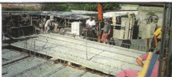
Por sus características, la construcción se mantiene más limpia, no requiere formaletear, reduciendo así el volumen del concreto.
