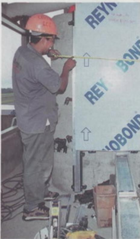
Las columnas internas están recubiertas de Reynobond, láminas de aluminio que brindan un acabado especial al concreto chorreado.
