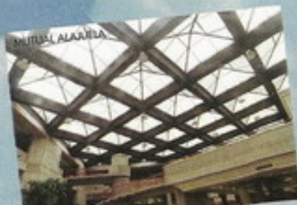
POLICARBONATO techos en láminas con protección UV
