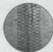
Tratamiento de juntas mediante el uso de tela metálica.
