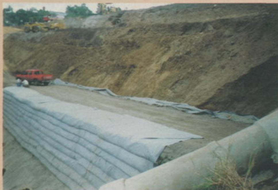
Talud Río María Aguilar
