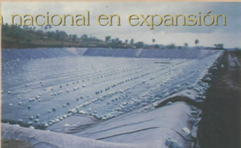
Protección de geomembrana en lagunas
