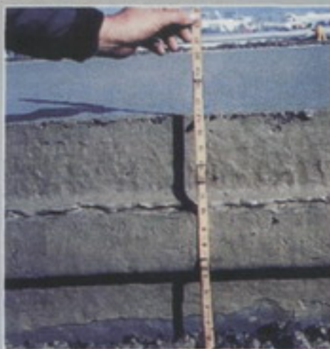
El espesor de un pavimento de concreto determina en buena medida el tiempo útil de la carretera, que puede superar los 30 años con bajísimo costo de mantenimiento.
