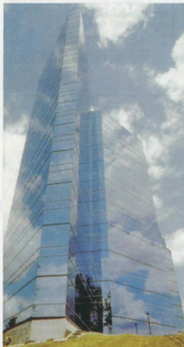
Foto 1. Edificio construido con placas en monotorón no adherido, obteniéndose una reducción en tiempo de entrega de 60 días y una altura menor del edificio de 3 metros.
