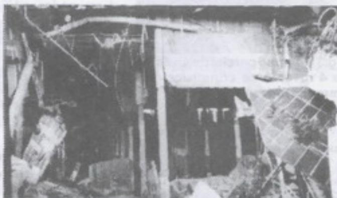
Fig. 8 Colapso de 2 niveles de éntrepiso en un edificio de tienda de departamentos. El sistema estructural consiste de losas planas nervadas apoyadas sobre columnas circulares de gran esbeltez.
