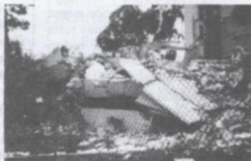
**Fig.17** Colapso total de un edificio de estacionamiento en un hospital. Estructura de 4 niveles formado por pórticos a base de vigas postensadas de gran luz y losa de concreto reforzado colada en sitio. En el sentido transversal el sistema carecía de vigas de amarre y de acción de pórtico.
