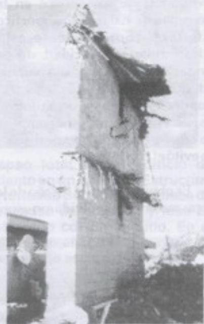
Fig.11 Muro estructural de corte correspondiente al edificio de estacionamiento mostrado en la Fig. 5. Debido al anclaje deficiente muro diafragma, la estructura se desprendió y sufrió colapso; el muro fue inefectivo y permaneció en pie sin daño aparente.
