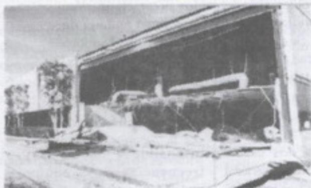
Fig.21 Colapso parcial de un edificio de construcción tilt-up. Las paredes exteriores se desprendieron y colapsaron debido a anclajes y conexiones deficientes entre paredes y el diafragma formado por la estructura de techo.
