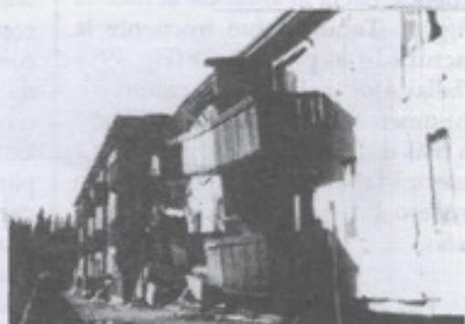
**Fig.20 Colapso parcial de un edificio de viviendas en condominio. Falla del primer nivel por efecto del piso blando. Estructura a base de artesanado de madera y doble revestimiento con láminas de madera contrachapada.**
