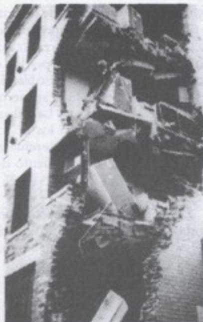
**Fig.3 Colapso parcial de un edificio de 4 niveles de construcción en mampostería sin refuerzo.**
