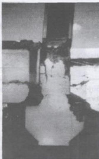
Fig.10 Apoyo simple de vigas prefabricadas sobre ménsulas dispuestas en las columnas. No se dispusieron barras de acero para proveer continuidad.
