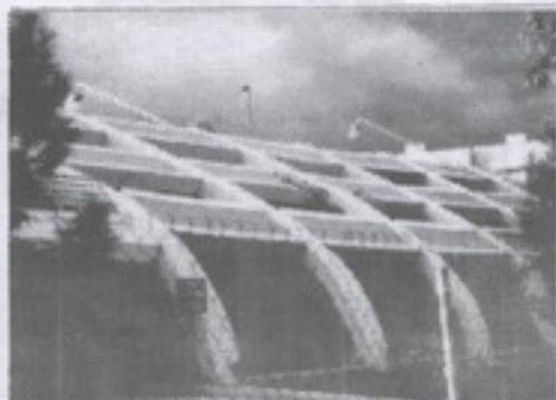
**Fig.13** Deformación de los pórticos exteriores este-oeste del edificio mostrada en la Fig.1. Sorprende la alta capacidad de deformación de las columnas; no obstante, la excelente ductilidad de los elementos verticales no compensó los errores conceptuales de estructuración, ni evitó el colapso de la obra.
