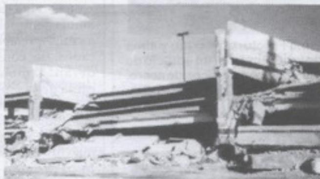
**Fig.5 Colapso total de edificio de estacionamiento de 3 niveles de construcción a base de elementos prefabricados.**
