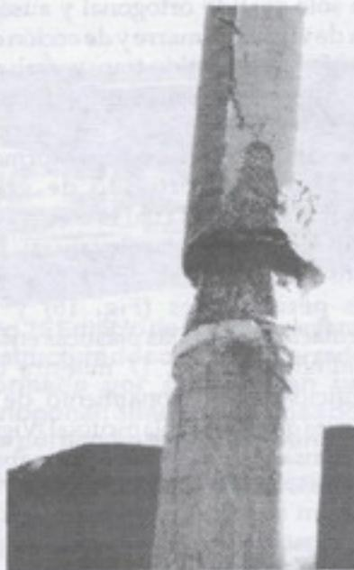
Fig.9 Columna correspondiente al edificio mostrado en la Fig.8. La conexión losa plana-columna carece de barras de refuerzo para proveer continuidad; no existen perfiles de acero para mejorar la resistencia a cortante y punzonamiento. La conexión no es capaz de proveer ni siquiera una débil acción de pórtico.
