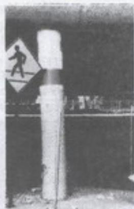
**Fig.16** Formación de rótulas plásticas en las columnas y deformación permanente del sistema. Corresponde a la obra mostrada en la Fig.15
