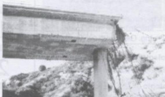
Fig. 2 El colapso de numerosos tramos de viaductos y puentes causó graves trastornos al sistema de transporte vial en la región noroeste del Gran Los Angeles.
