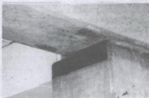
**Fig.14** Apoyo simple y conexión seca viga-columna mediante soldadura de perfiles y anclajes de acero.
