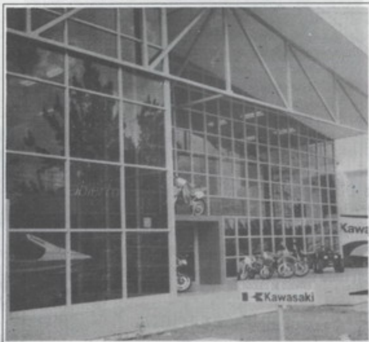
Oficinas Centrales Kawasaki, Paseo Colón
