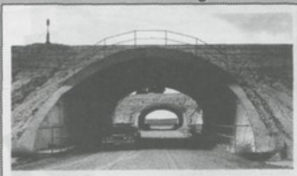
Pasos inferiores de acero corrugado de gran luz...
