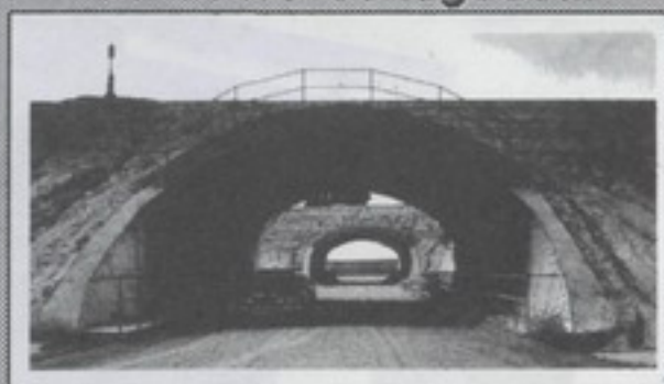
Pasos inferiores de acero corrugado de gran luz...
