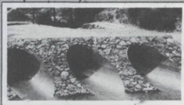
Tuberías biseladas de acero corrugado...
