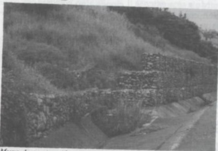
Muro de contención de la carretera San José - Cartago, Costa Rica
