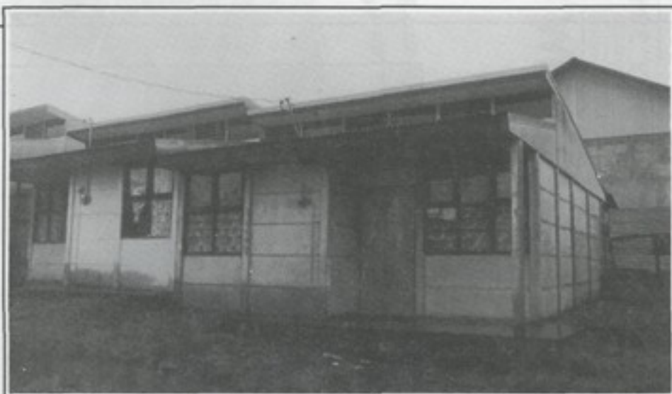
La fotografía muestra uno de los sistemas de construcción de viviendas prefabricadas en Costa Rica
