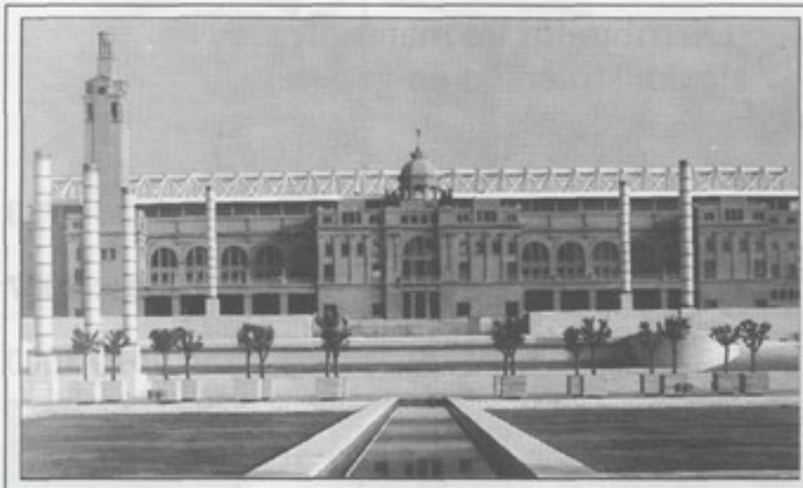
Estadio Olímpico de Montjuïc: remodelado por Vittorio Gregotti y Correa & Mila, donde se desarrolló la ceremonia de apertura.
