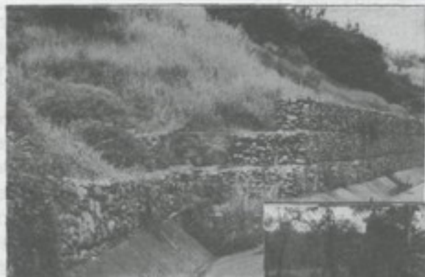
Muro de contención de la carretera San José - Cartago, Costa Rica.
