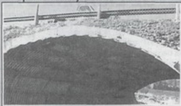
Tuberías abovedadas de acero corrugado...
