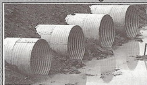
Tuberías corrugadas para avenamiento...
