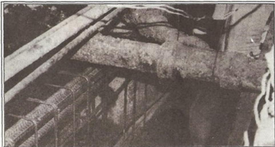
Figura #24. La construcción de vigas de acople a nivel de fundación usualmente presenta problemas constructivos que deben ser resueltos en sitio.
