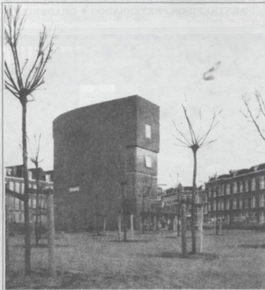
Vista general desde el noroeste del edificio y su entorno.
