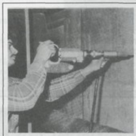
Figura # 3 Se debe garantizar en un 90% la penetración del epóxico.
