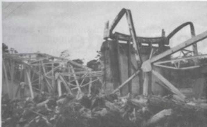
**Colapso de un puente por fallamiento del terreno.**
