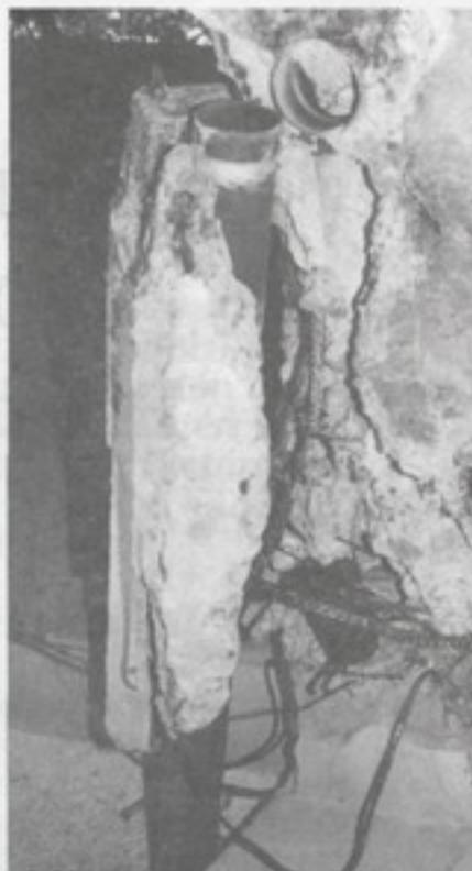
**Efectos sobre una columna en la cual se puede observar una cañería de desagüe.**
