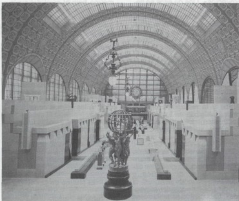
El hangar de la estación de Orsay remodelado para instalar el Museo del siglo XIX (conservando en el subsuelo el tráfico ferroviario remanente).
