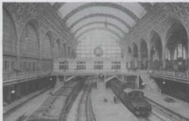
El hangar de la estación de Orsay en su estado original hasta 1900.
