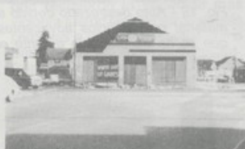
Fig. 8 - Colapso típico de un parapeto de ladrillo sin refuerzo en Watsonville.
