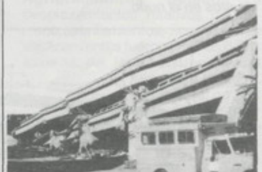
Fig. 19 - Colapso trágico de aproximadamente 1,5 km del segundo nivel del "Paso Cypress".
