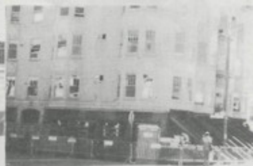
Fig. 11 - Elementos de madera a 45 grados arriostran lateralmente a este edificio de "Piso Suave" ubicado en La Marina, San Francisco. Otros elementos de madera contribuyen a resistir las cargas gravitacionales.
