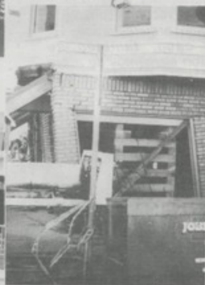
Fig. 12 - Detalle del edificio de la Fig. 11. Gatas hidráulicas levantarán y desplazarán lateralmente el edificio para colocarlo en su posición original, antes de iniciar la reestructuración.
