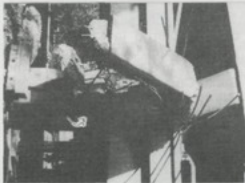
Fig. 21 - Detalle típico de un gozne. Superficies lisas y varillas al centro no permiten una transmisión del momento.
