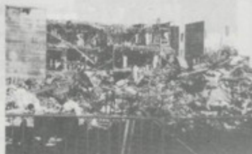
Fig. 9 - Destrucción de un edificio en La Marina, San Francisco, debido al fuego originado por el sismo.
