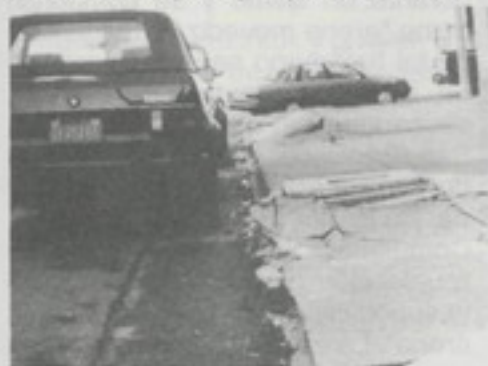
Fig. 5 - Daños en las aceras de La Marina, San Francisco debido a desplazamientos laterales del terreno.
