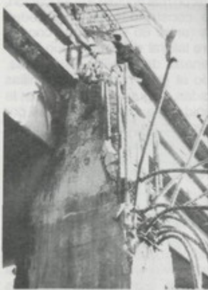
Fig. 22 - Detalle típico del nudo fallado. Nótase la gran cantidad de acero longitudinal en las columnas y la ausencia de aros en el nudo.
