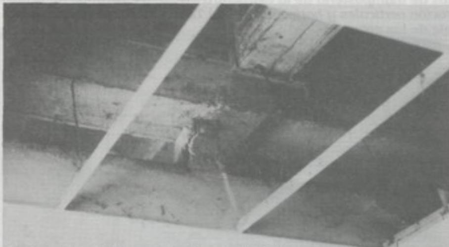
*Fig. 21 - Hospital de Niños Benjamín Bloom, San Salvador - Los tabiques interiores han sido separados del entrepiso superior y están unidos a éste mediante elementos cortos de concreto reforzado que proveen a las paredes estabilidad lateral; durante un sismo esta columnetas actúan como fusibles y no restringen el desplazamiento lateral de la estructura. Esta medida constructiva evitó daños secundarios cuantiosos a la mampostería.*
