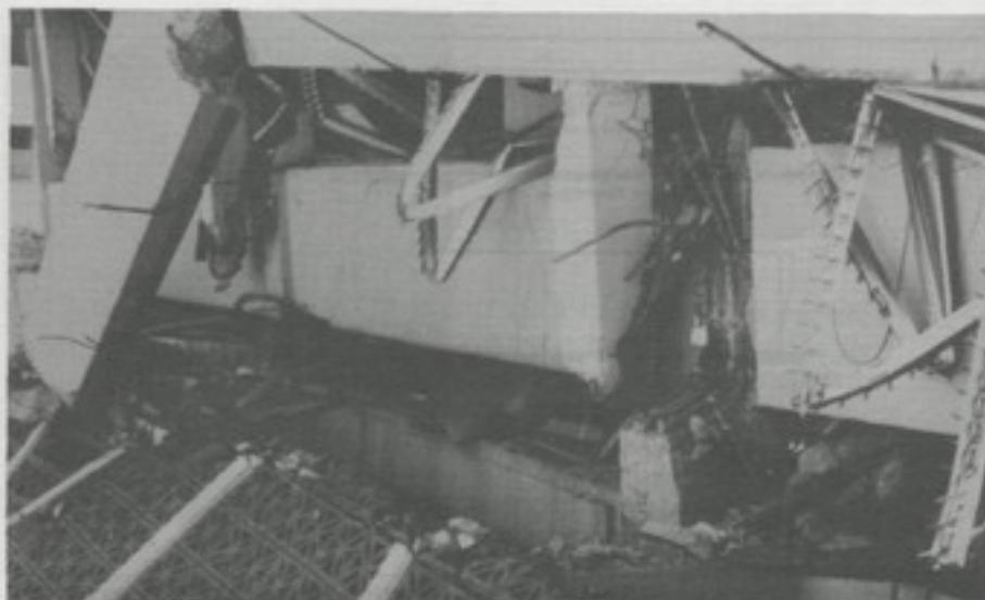
Fig. 7 - Falla en cortante por efecto de columna corta en el Hospital de Niños Benjamín Bloom, San Salvador; la consecuencia fue el colapso de dos secciones de 3 pisos - Terremoto 1986
