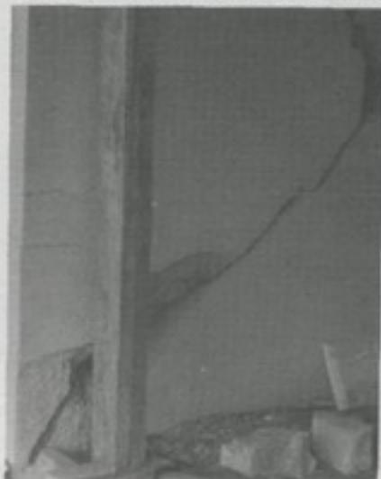
Fig. 9 - Falla en cortante de una columna debido a la interacción de tabiques de mampostería. La componente horizontal de la resultante diagonal causa la falla del elemento.
