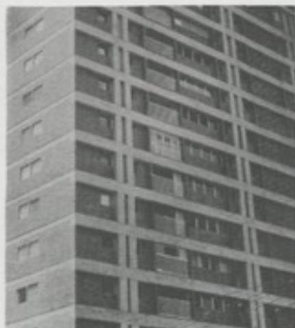
Fig. 1 - Edificio con estructura a base de pórticos flexibles de concreto reforzado con paredes de mampostería que rigidizan el sistema, modificando su comportamiento.
