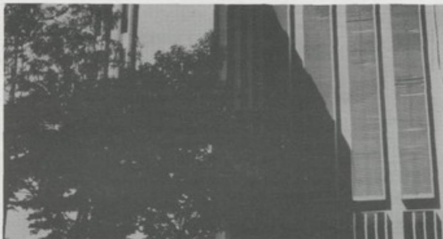
*Fig. 19 - Facultad de Medicina, Universidad Nacional de El Salvador - La estructura a base de pórticos de concreto reforzado, mostró buen comportamiento en el terremoto de 1986. Juntas de separación entre tabiques y sistema resistente evitaron el efecto de columna corta y daños a la mampostería.*
