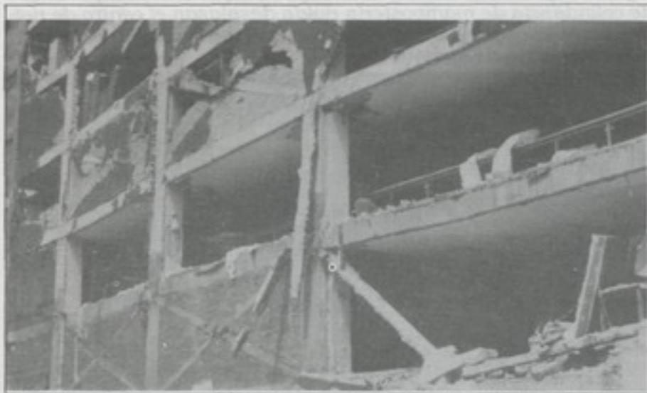
Fig. 15 - Daños severos y desprendimiento de paredes de mampostería a consecuencia del terremoto de México D.F. 1985. Los daños a la tabiquería pueden representar pérdidas económicas cuantiosas y sacar un edificio fuera de operación.
