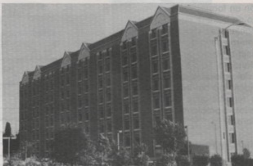
Edificio "Whittier Hilton", después del sismo de octubre de 1987.
