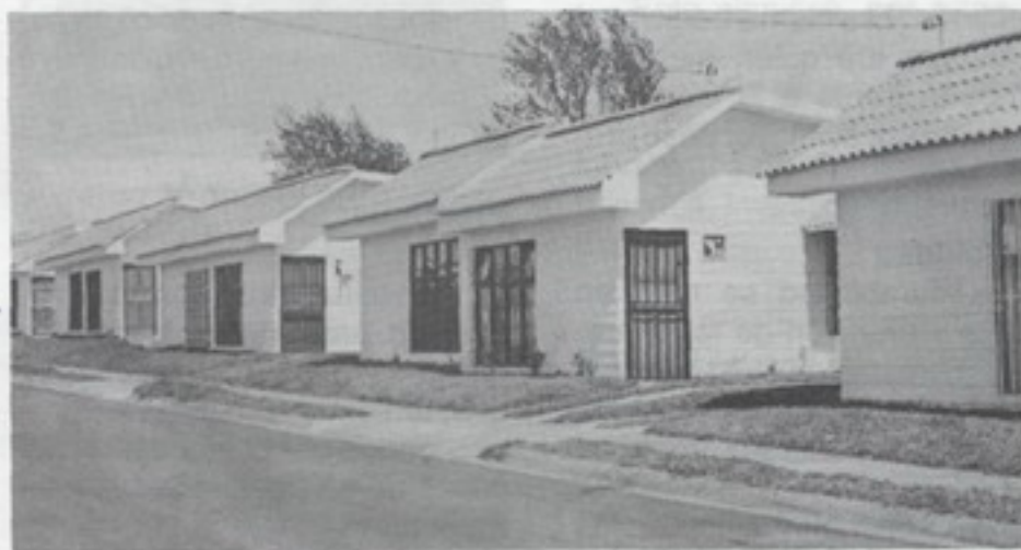
Elementos prefabricados para viviendas en serie.
