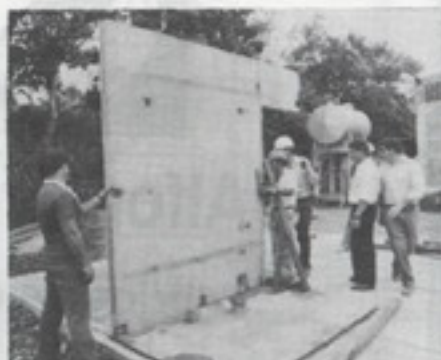
Elementos prefabricados para edificios de Productos de Concreto.
