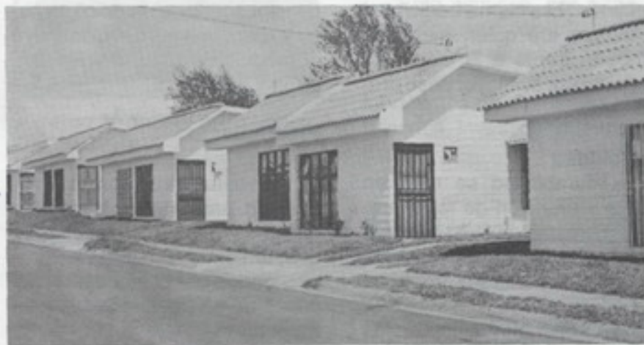
Elementos prefabricados para viviendas en serie.
