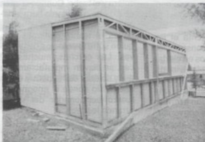
Instalación Muro-Seco Ricalit.
