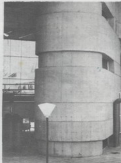
Volúmen cilíndrico que encierra uno de los dos núcleos de escaleras.
