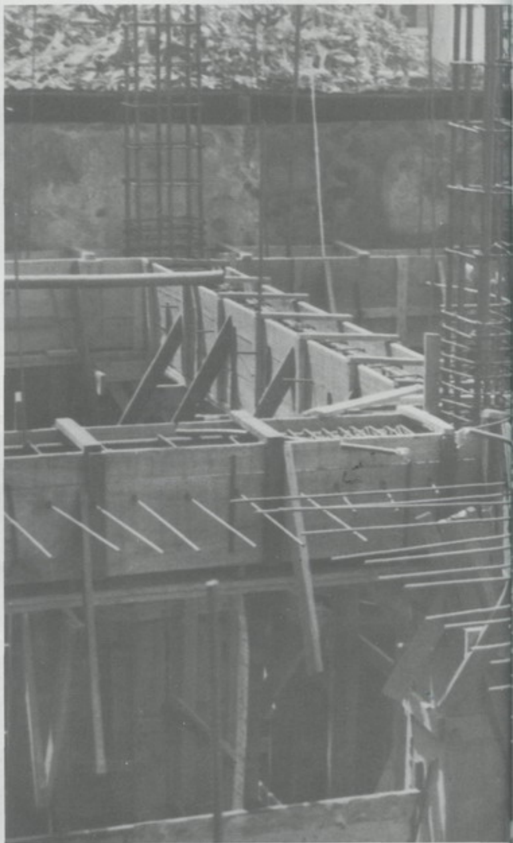
Panorámica de un sistema de laterales y puntales que sostiene
