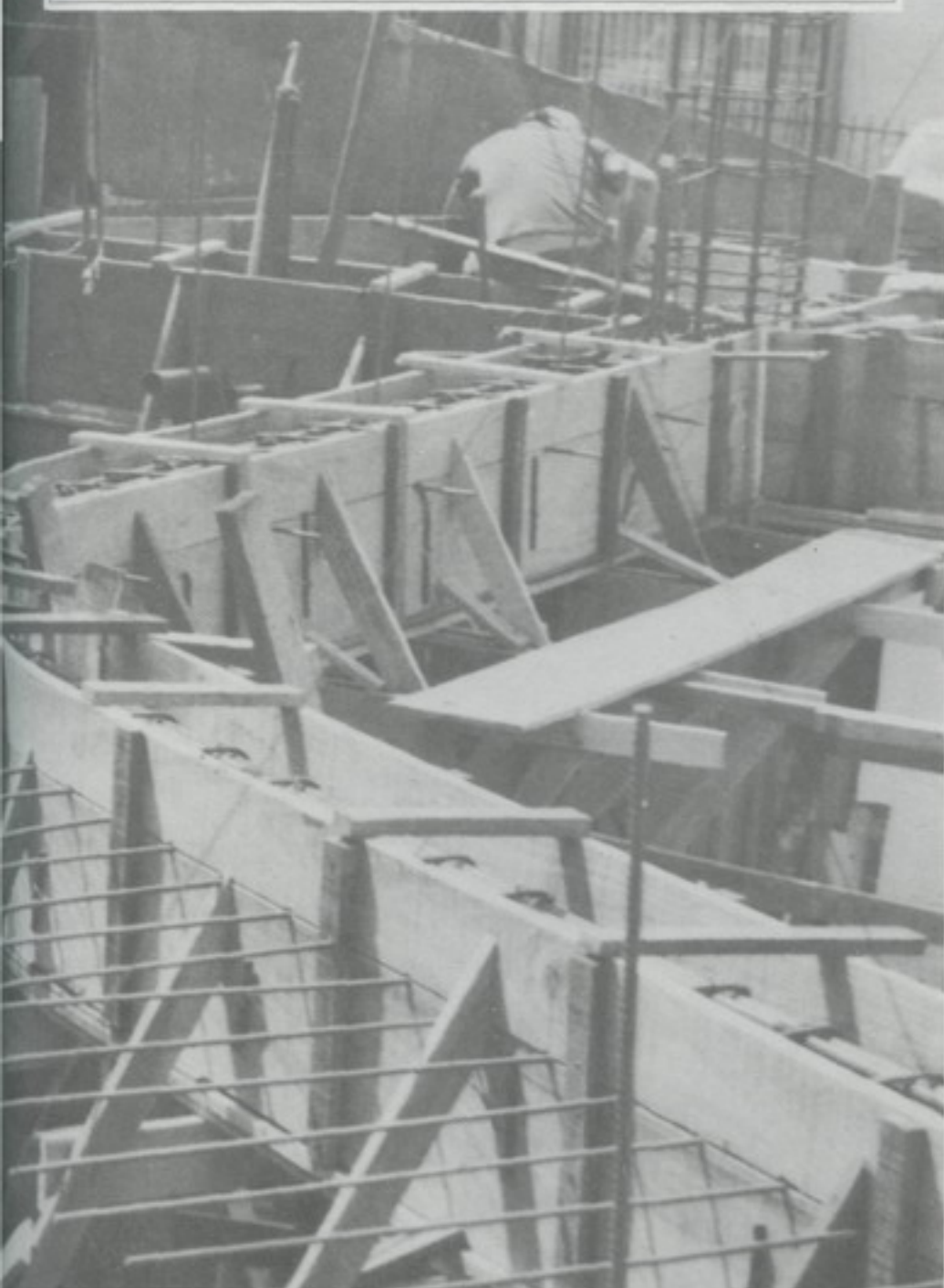
encofrado para vigas con sus nen los fondos de vigas.
