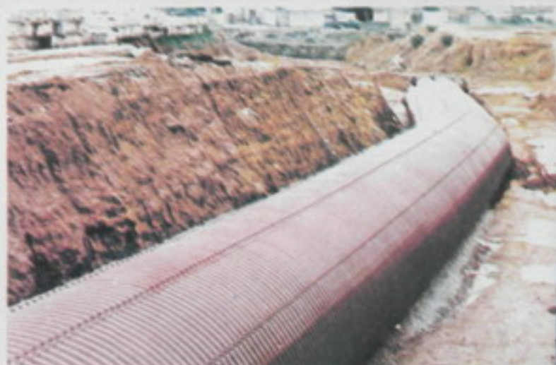
Para Colectores Pluviales
