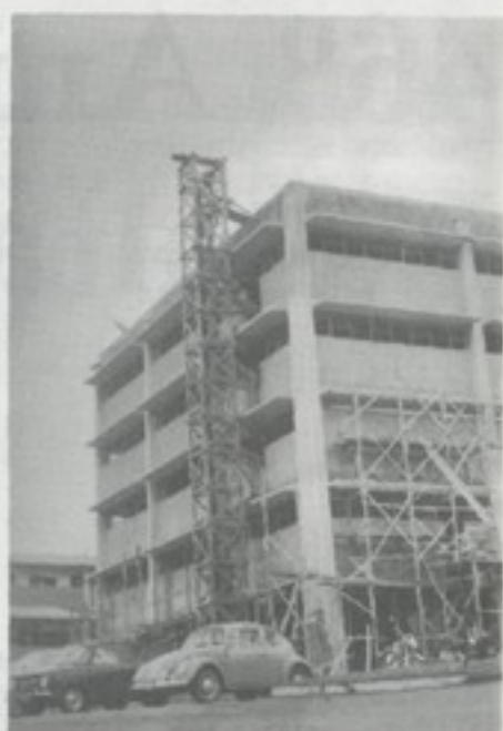
Construcción de la escuela de Ingeniería -1974
