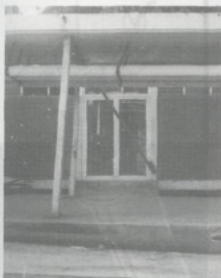
Figura 11 Pasillo de Cuarto de Máquinas Hospital General
