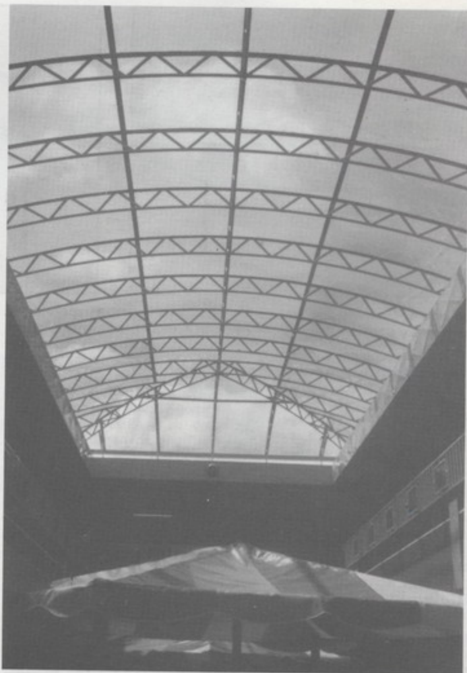
Aquí pueden observarse claramente las cerchas de tipo “espacial” que instaló el Taller Ramírez
