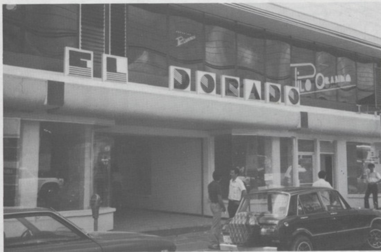
Frente al nuevo centro comercial. Los ventanales ahumados están hechos con 14 láminas de acrílico Humo de 6.4 mm (1/4") de espesor. Algunos ya han sido rotulados.
