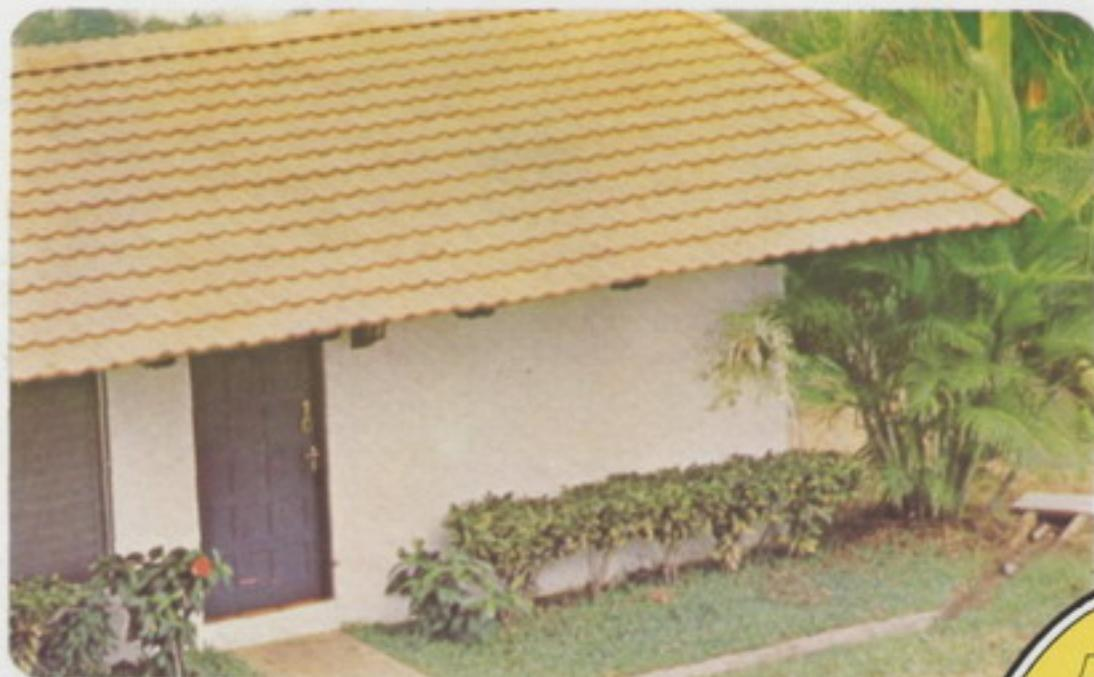
Las Tejas Mediterráneo de cemento se fabrican en diferentes colores, incorporados en la masa. Son totalmente impermeables; son mucho más resistentes que una teja normal y son aislantes térmicas y acústicas.
