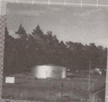
Tanque Elevado para Agua 75 m 3 de capacidad
