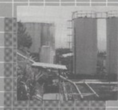
Planta de Emulsiones Asfálticas
