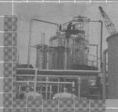
Planta de Tratamiento de Aguas Recope-Limón
