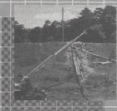
Puente Colgante para Tubería Rio Reventado
