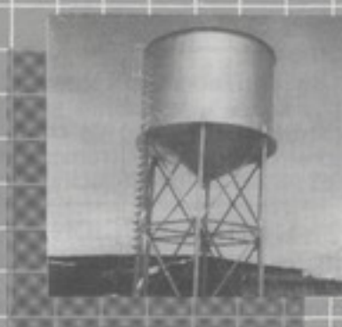
Tanque Elevado para Agua 75 m 3 de capacidad
