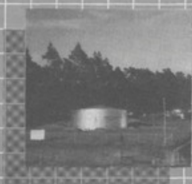
Tanque para Agua, 1000 m 3 Ochomogo
