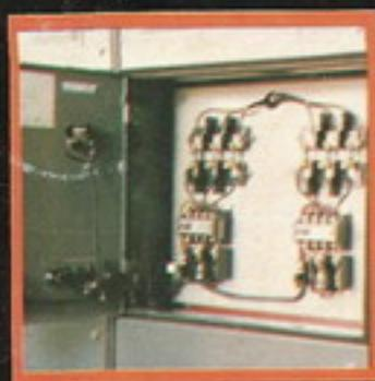
Con fusibles con capacidad de corto circuitos de hasta 200.000 Amp. RMS simétricos que, entre otras ventajas le ofrece:
