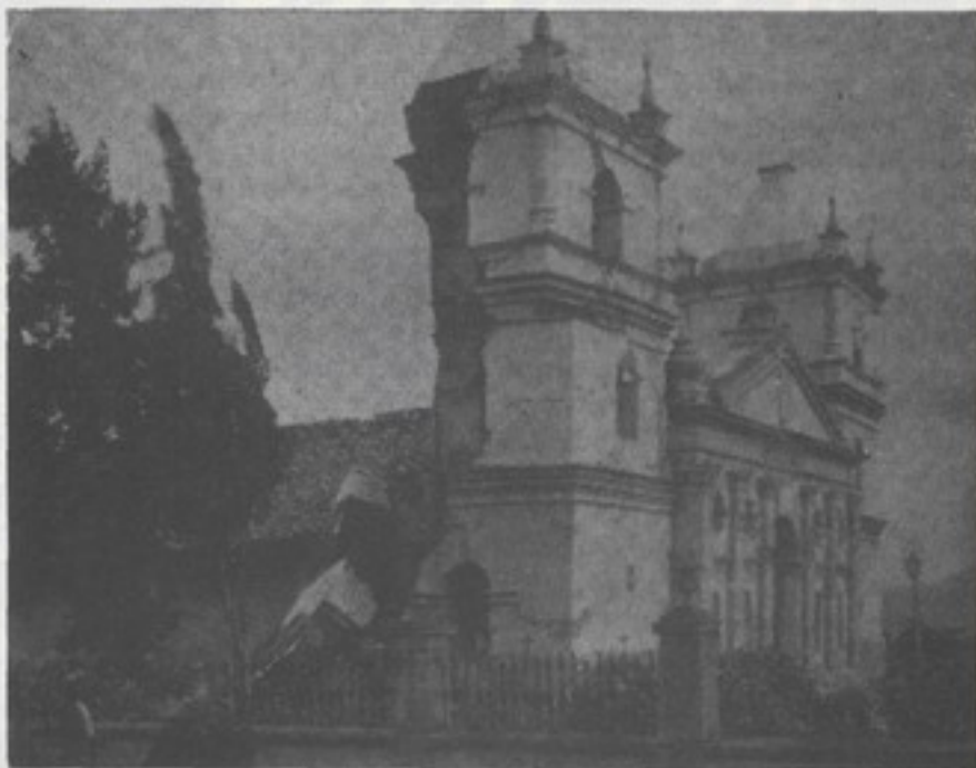
La Iglesia de la Virgen de los Angeles destruida por el terremoto de 1910.
