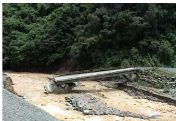
El puente para transportar materiales sufrió severos daños por la inundación.
