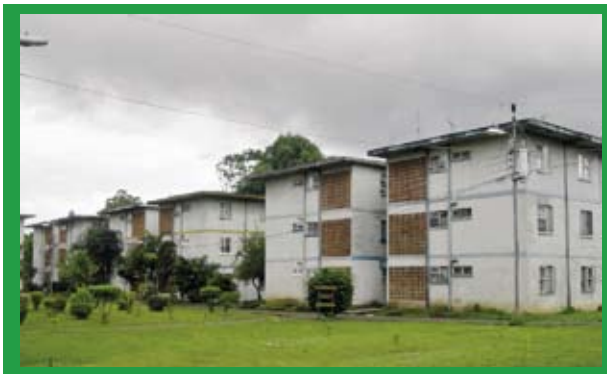
Proyecto de edificios multifamiliares (VIS), construidos en los años sesenta. Ubicación: El Carmen de Desamparados, San José.
