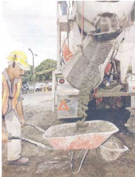
Los especialistas recomiendan que se utilice una batidora para mezclar los materiales necesarios para crear el concreto preparado en obra. ARCHIVO
