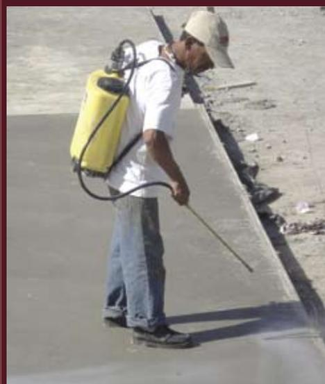
Curado del concreto conmembrana
