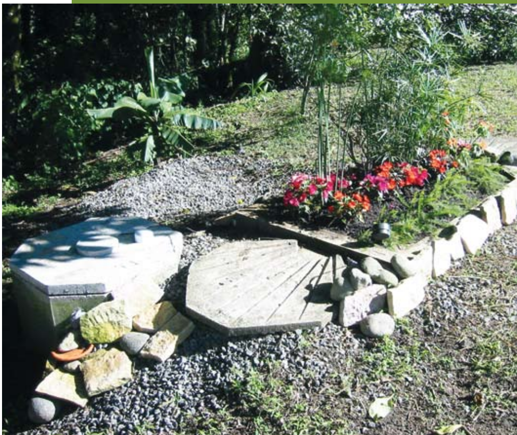
Filtro de depuración ornamental, con plantas y sistema de desinfección, instalado
