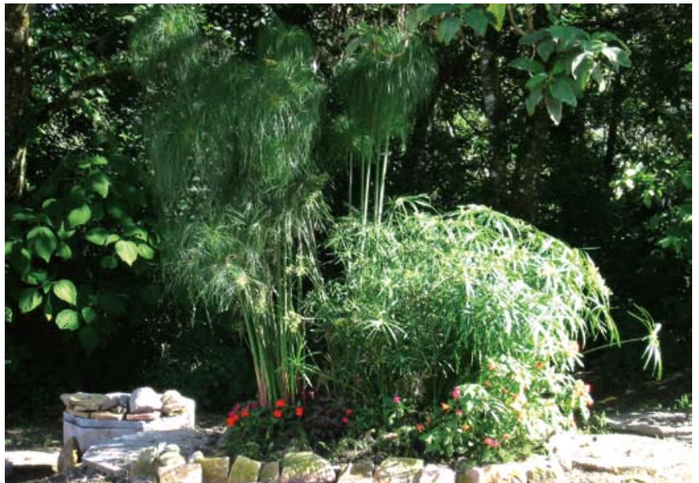
Filtro de depuración ornamental, después de 6 meses de instalado
