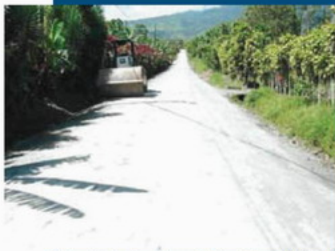
Proyecto de mejora de base. Camino Intersección Ruta 415 Guayabo Abajo - Monumento Nacional Guayabo.
