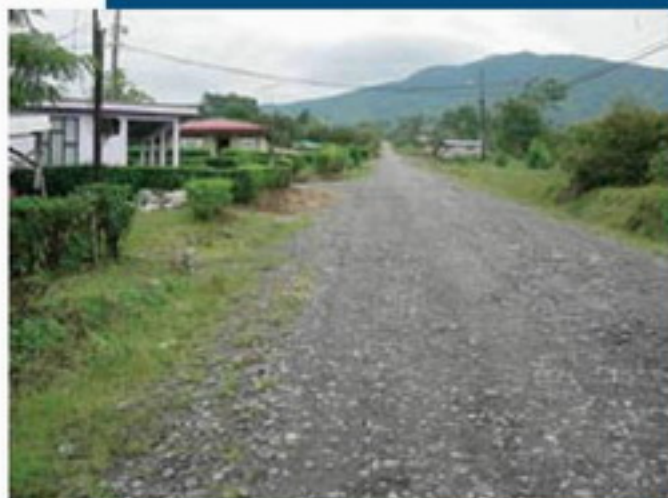
Calle que comunica Intersección Ruta 415 Guayabo Abajo - Monumento Nacional Guayabo.
