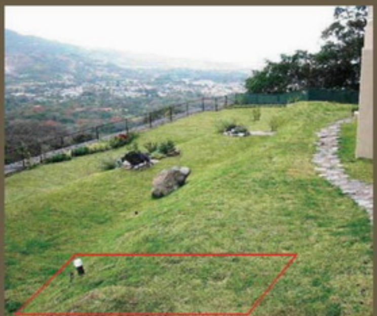
Ubicación de la Planta de Tratamiento completamente enterrada y en operación
