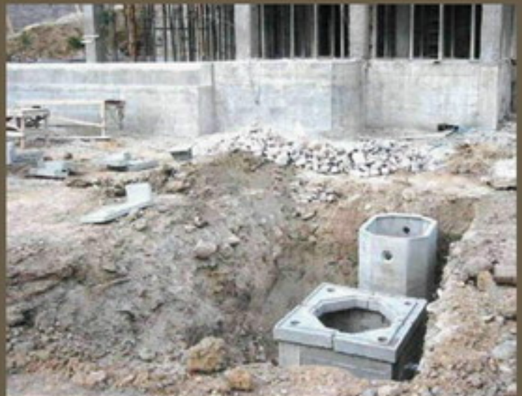
Planta de tratamiento en fase de instalación
