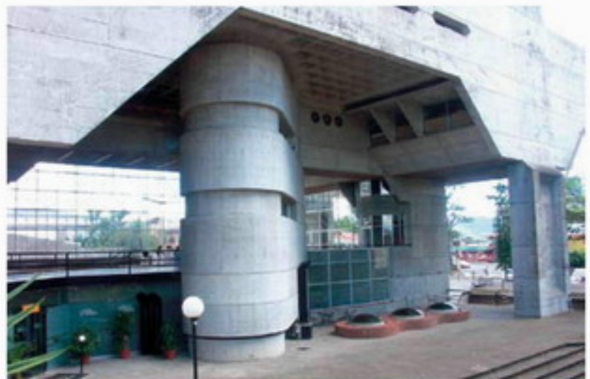
Fachada Oeste del edificio del CFIA
