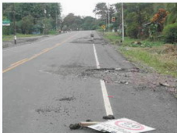
Daños en la superficie de rueda, los cuales evidencian una desintegración total de los bordes derechos con importantes sectores removidos.
