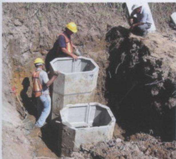
T.D. pueden estar completamente enterradas así como semienterradas o bien fuera de tierra. La colocación final de las unidades dependerá mucho de las características del terreno y de las necesidades del cliente. Recordamos que es un sistema "cerrado".
