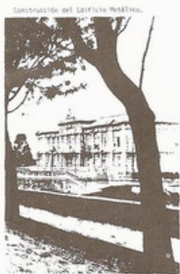
Construcción del Edificio Metálico.
