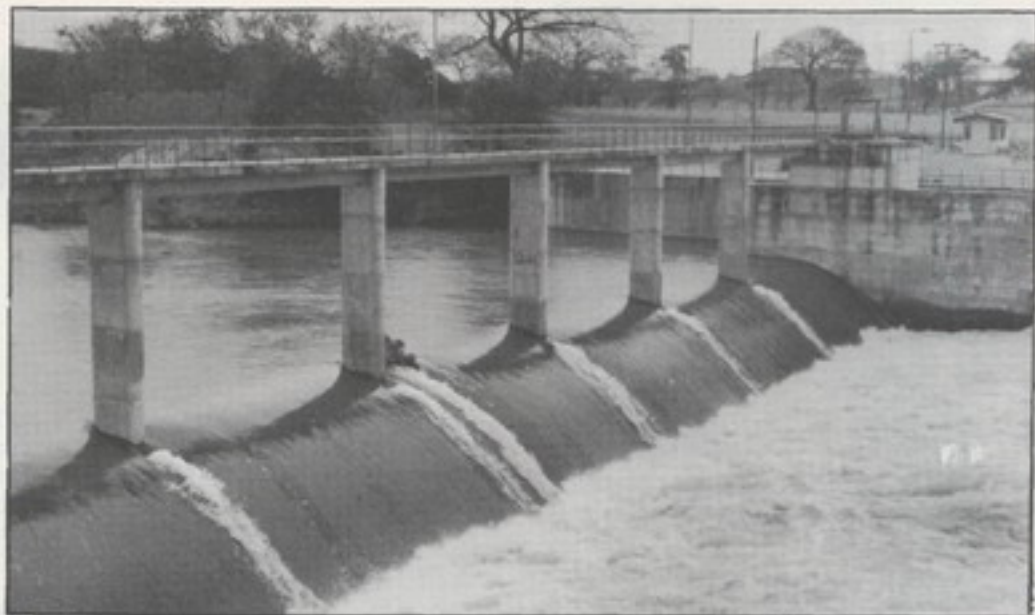
Presa de Magdalena, tipo gravedad vertedora. Es el punto de partida del Proyecto de Riego Arenal. Tempisque
