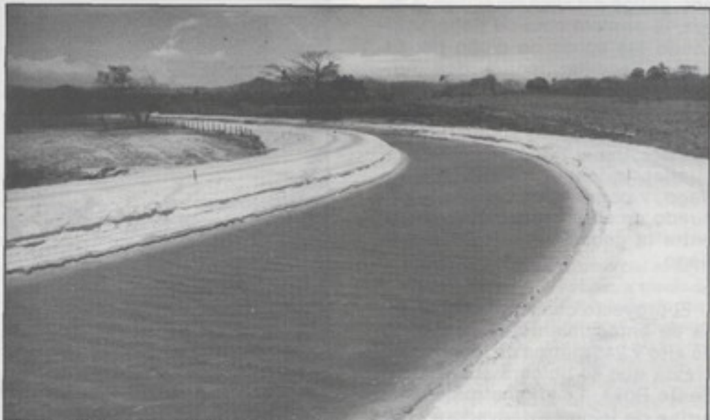
Canal del Sur, construido por el ICE en un tramo de 10 Km. Junto con el del Noroeste, constituirán las dos arterias básicas del Proyecto de Riego
