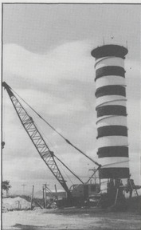
Tanque de oscilación de Corobicí, de 97,5 m. de altura por 18 m. de diámetro
