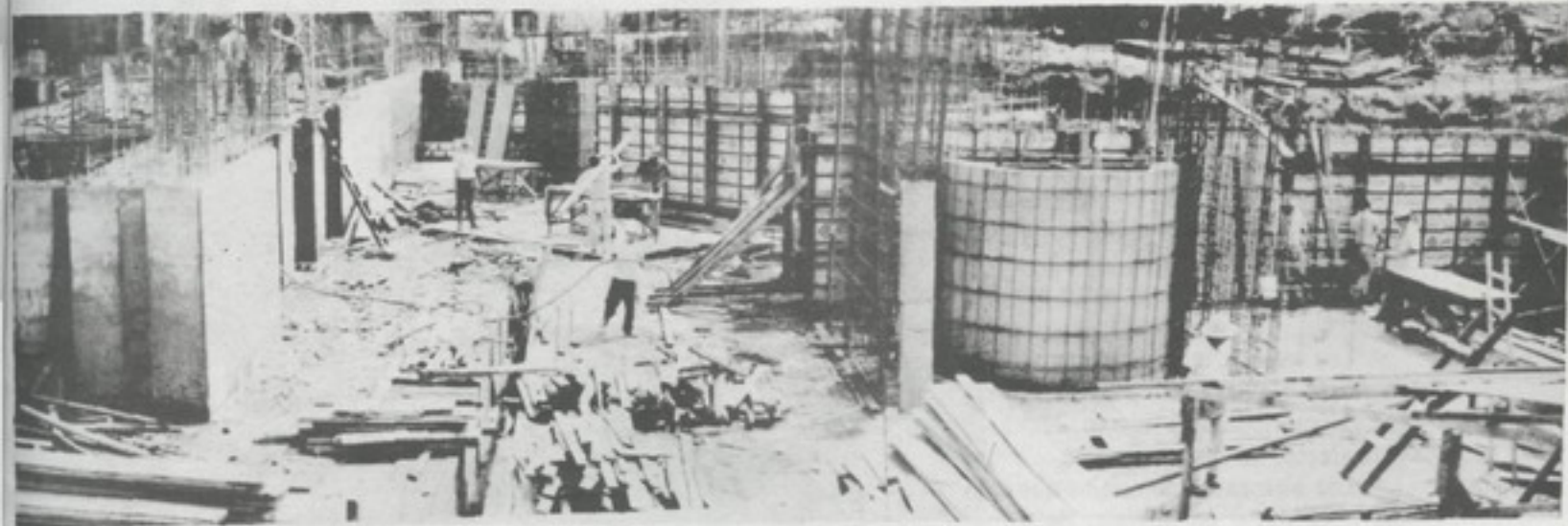
Vista general del nivel 98.95 (Planta de acceso).
