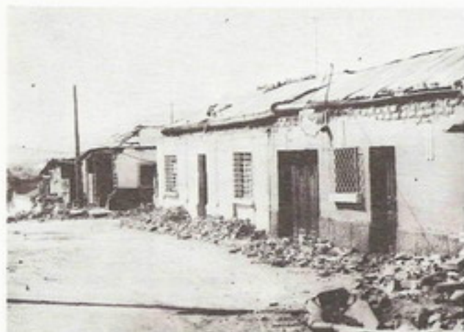
En la ciudad de Guatemala la intensidad fué moderada, grado VI en la escala Mercalli Modificada. El daño a construcciones de adobe fué relativamente reducido y no se observa en forma generalizada.
