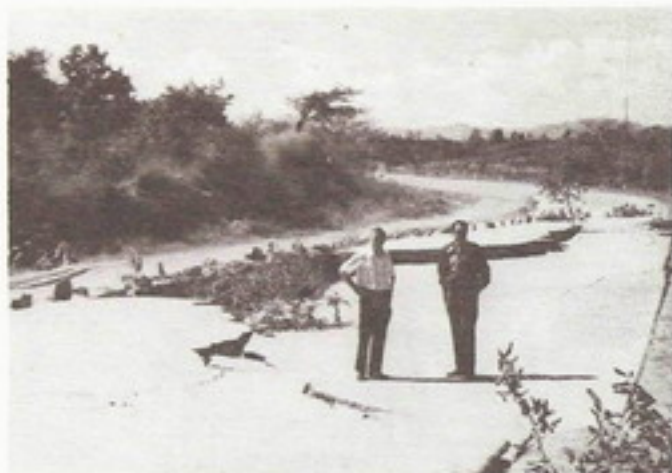
El sismo produjo grandes cambios geológicos, entre ellos deslizamiento de taludes y terraplenes, asentamiento de rellenos, etc.
